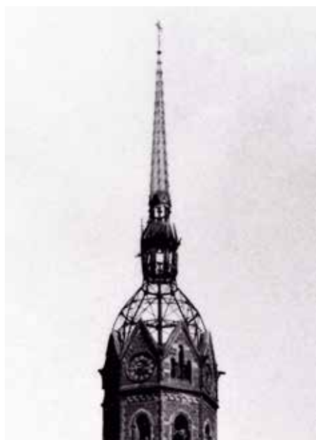
Der Turmhelm nach Kriegsende. Die Stahlkonstruktion konnte zur Neueindeckung mit Kupfer wieder verwendet werden. Nur die Spitze oberhalb der Laterne blieb original.
